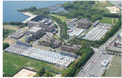
湖西浄化センター(大津市苗鹿)
