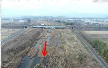
写真⑤ 鴨川:伐木・伐竹(R7.3撮影)
