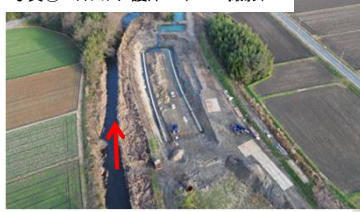
写真③ 安曇川:護岸工(R7.4撮影)
