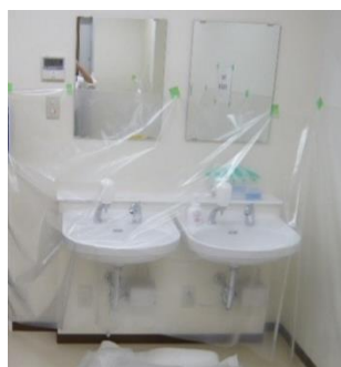
付属図2.3 搬出できないものの養生の例
