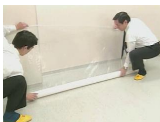
付属図2.4 壁面の養生（立ち上げ）の例
