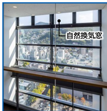
東西両端の2層吹抜け空間
