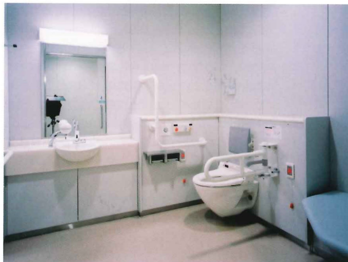
行政庁舎基準階の多目的トイレ(男女トイレ内に設置)
