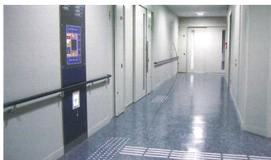
廊下の誘導ブロック、触知案内サイン、手摺
