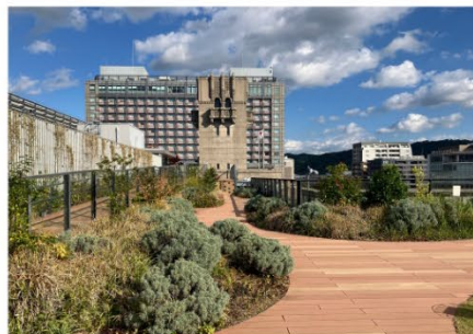
参考例:京都市庁舎屋上庭園
