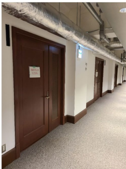
地階改修事例:京都市本庁舎地下 (会議室、執務室)
