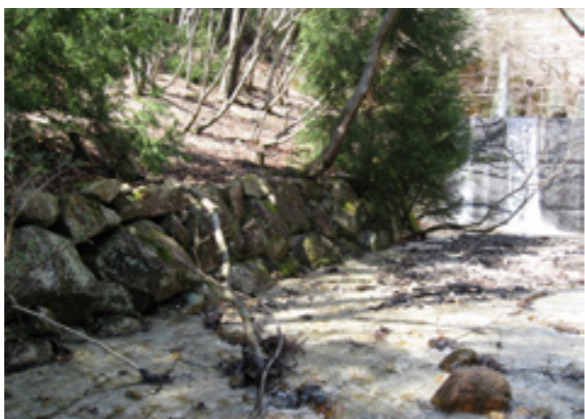
図3 家棟川上流石堤跡と砂防堰堤
