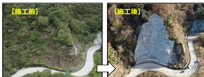
法面对策の状況【国道306号/多賀町】
