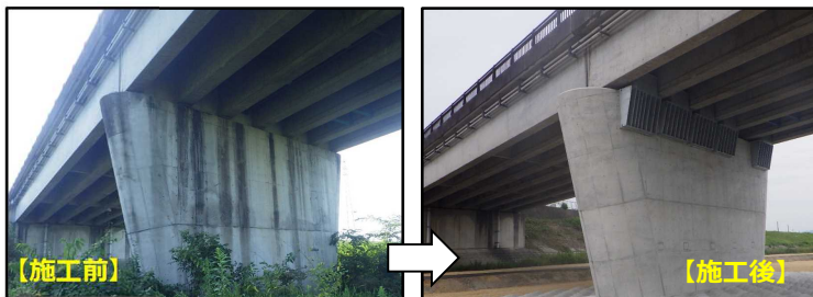
耐震補強の状況【近江富士大橋/野洲市】
