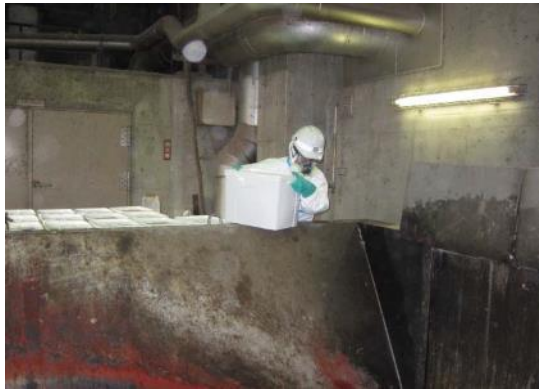
焼却施設での作業
