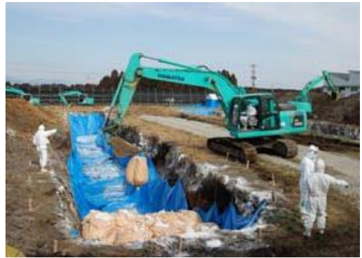
埋却地での作業
