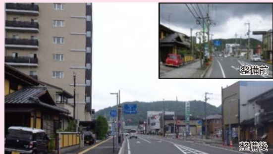
野洲停車場線（野洲市） 無電柱化によって、災害に強く開放感ある景観を形成しました。
