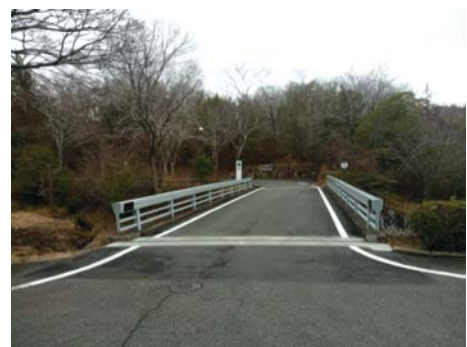
希望が丘文化公園橋梁修繕(友情の橋)工事(令和8年2月完了)
