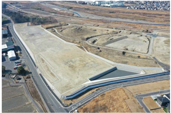
滋賀県立高等専門学校造成工事(令和8年3月完了)
