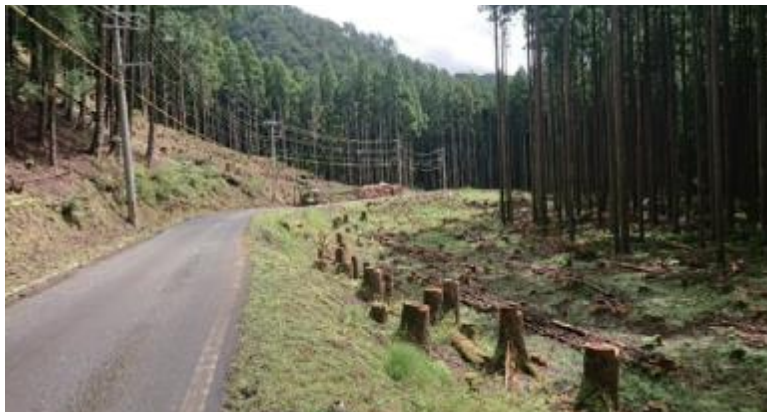
道路沿いの予防伐採を行った現場
