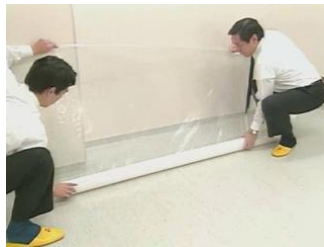
付属図2.4 壁面の養生（立ち上げ）の例
