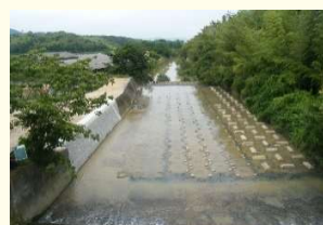
河川工事完了状況
