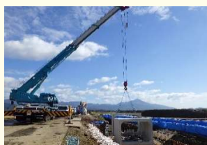
ボックスカルバート据付状況
