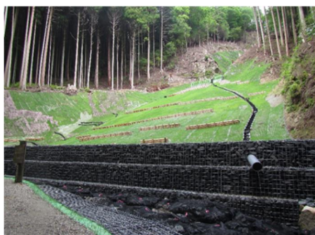
治山工事(木柵工・木筋工)
