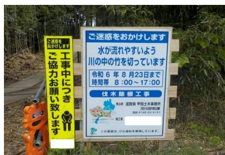
河川の維持管理工事(工事看板)
