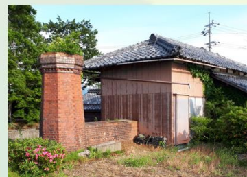
龍ヶ池揚水機場
