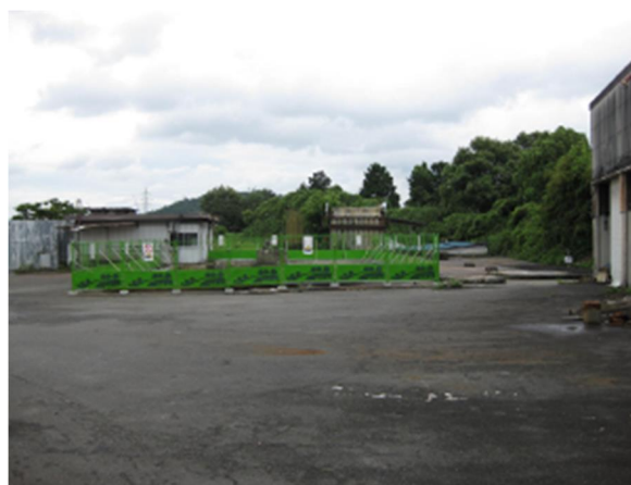
南側焼却炉解体撤去後
