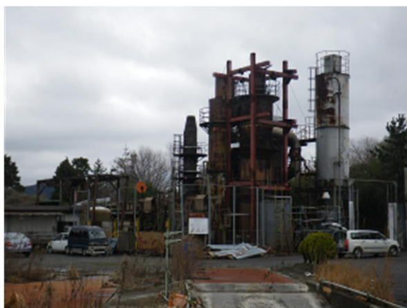
南側焼却炉解体撤去前
