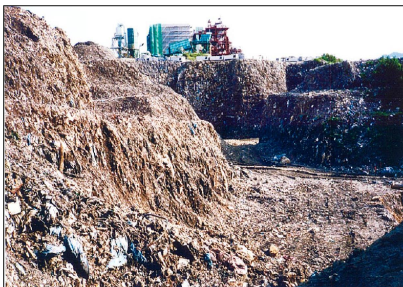
旧処分場とその上に建つガス化溶融炉 (住民提供)
