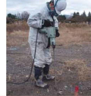
写真-3 ハンマードリルの掘削状況
