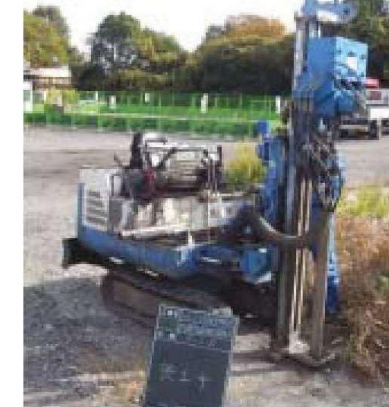
写真-2 掘削マシンの掘削状況
