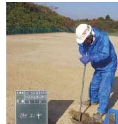
写真-1 ハンドオーガーの掘削状況
