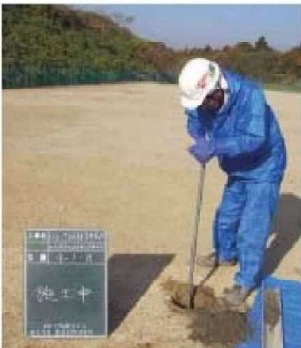
写真-1 ハンドオーガーの掘削状況
