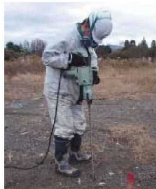
写真-3 ハンマードリルの掘削状況
