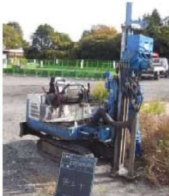
写真-2 掘削マシンの掘削状況
