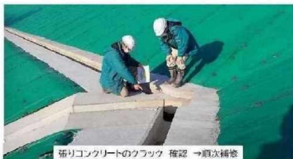
張りコンクリートのクラック 確認 → 順次補修
