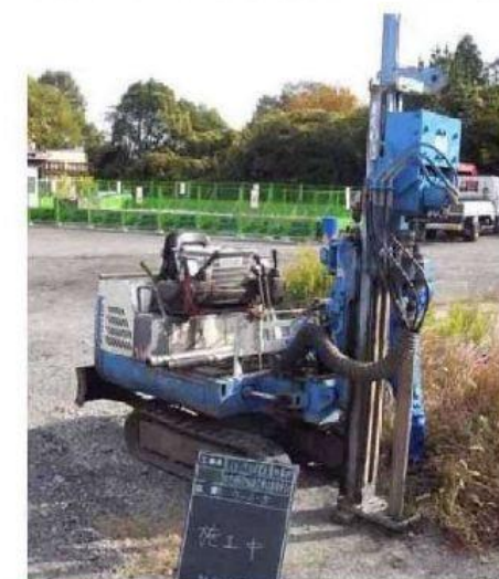
写真-2 掘削マシンの掘削状況
