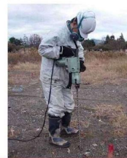
写真-3 ハンマードリルの掘削状況
