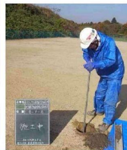
写真-1 ハンドオーガーの掘削状況
