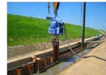
鋼矢板打設 施工写真(例)
