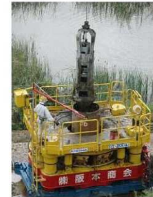
オールケーシング工法 施工写真
