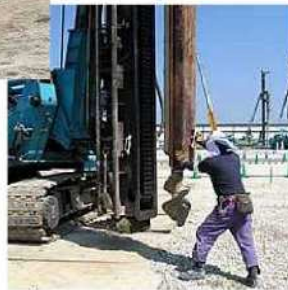
オーガ併用圧入工法 施工写真(例)
