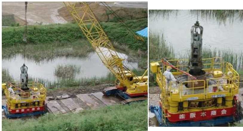
オールケーシング工法 施工写真(B工区No.5揚水井戸設置時)
