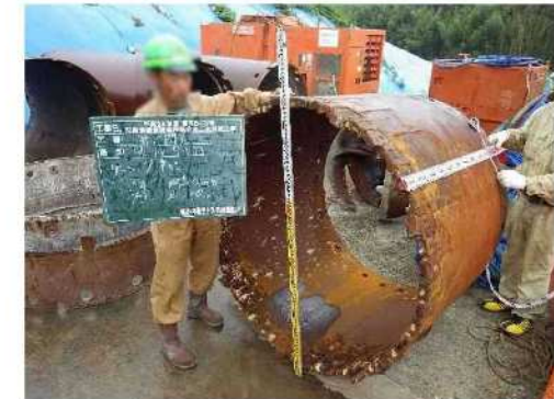
オールケーシング工法 金属刃
