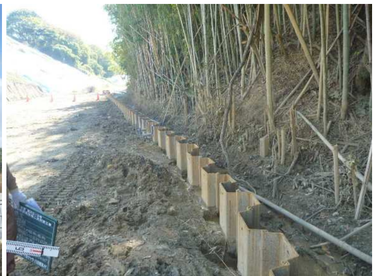
打設が完了した矢板
