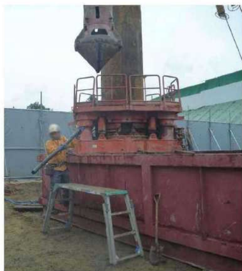
全旋回掘削機
