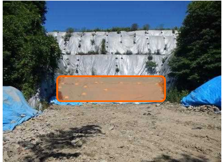
現在の仮置き状況
