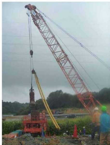
全旋回掘削機 クローラクレーン
