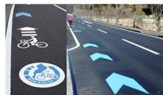
矢羽根による路面表示と案内整備
