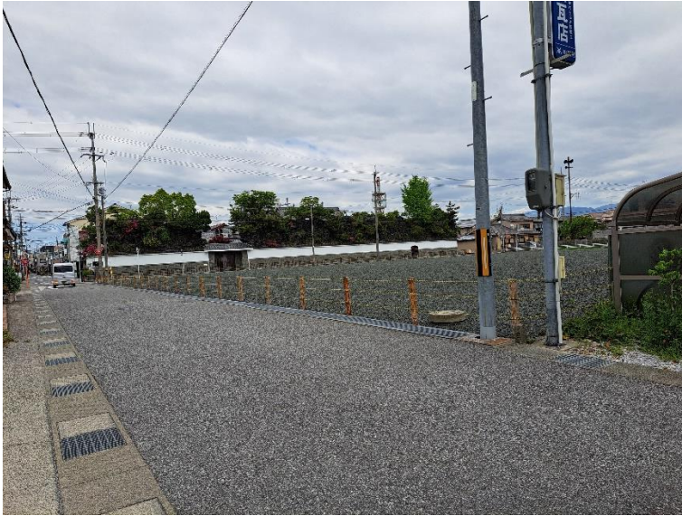
⑤南東側より(占用橋)
