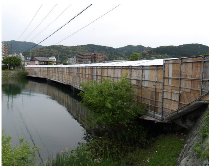
工事中の尾花川橋
