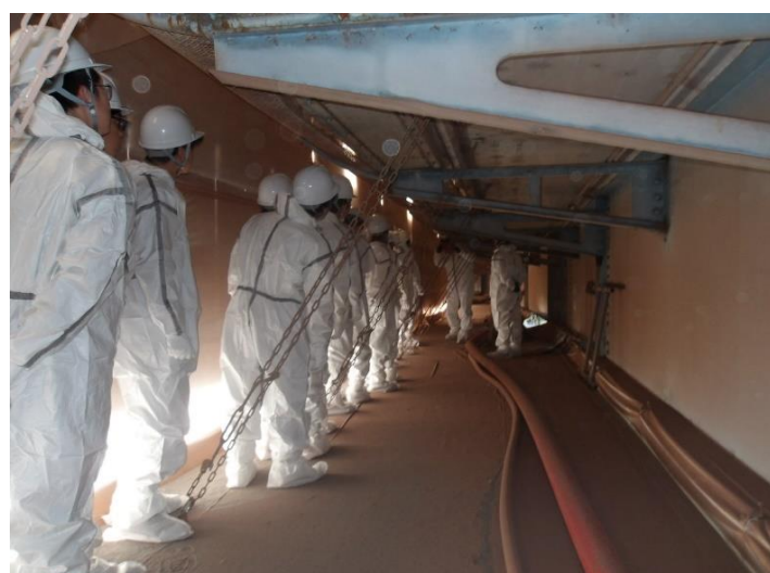
部材の塗装状況を見学
