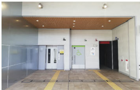
エレベーター・バリアフリースイートの整備（石部駅）
