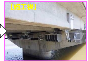
橋脚補強の状況【野田橋】
