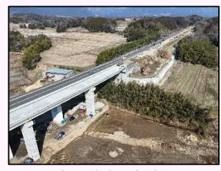
▲R161 湖西道路 4車線化
