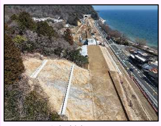
▲R161 小松拡幅 14工区
