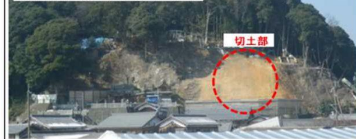
法枠施工前（2016年2月）
