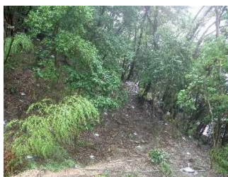
巨木、高木を残した工法
