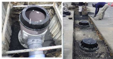
マンホールトイレ設置
