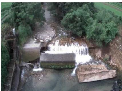
大雨により旧農業用水取水堰が崩壊（施工前）
