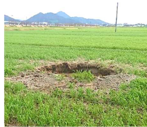
パイプラインの損壊による農地の陥没事故
