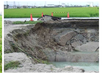
パイプラインの損壊による農地の陥没事故
