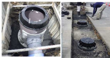
マンホールトイレ設置
