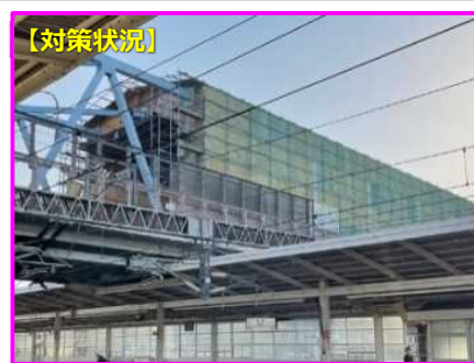
損傷・修繕（塗装塗替）状況【米原跨線橋】
