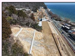
▲R161 小松拡幅 14 工区
