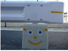
SPC基礎ブロック
