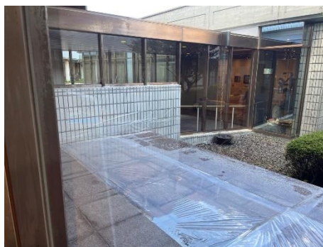
雨水侵入のためビニールで養生した回廊と外壁
