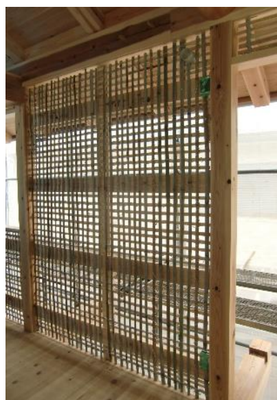
貫工法の施工写真（例）
