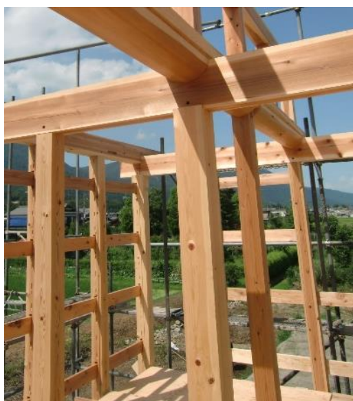
貫工法の施工写真（例）
