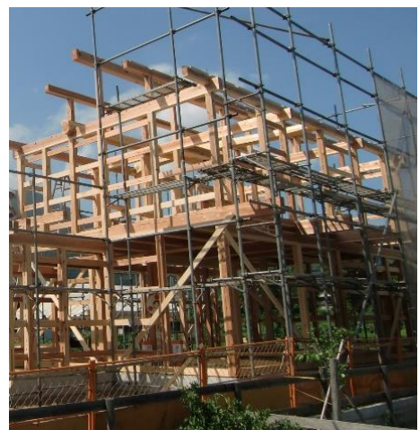
建込完了の写真（例）
