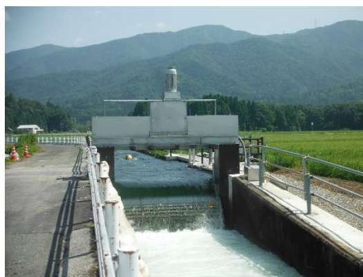
湖北中央幹線発電施設 3 号 (長浜市高月町)
