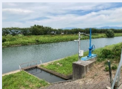
農業用水利施設の監視カメラ (彦根市薩摩町)
