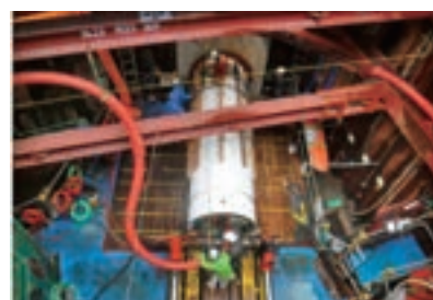
管水路の保全更新
