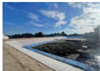
改修中のため池
