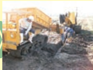
暗渠排水による汎用化
