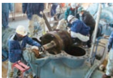
ポンプの機能診断
