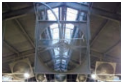
換気扇の設置
