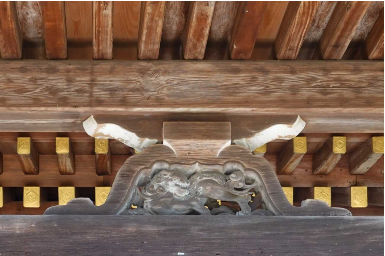
向拝臺股および桁の彩色の痕跡
