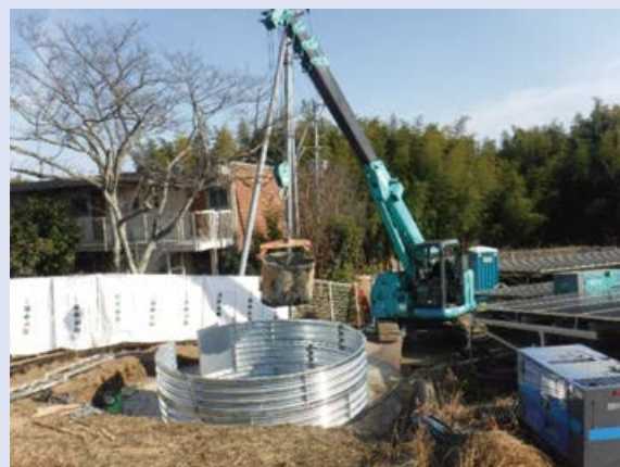
地すべり防止対策 (集水井工の組立て、設置状況)
