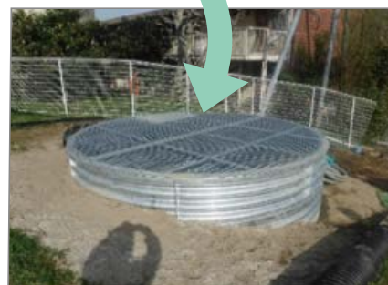
【地すべり対策】 集水井工、水抜きボーリング工 (大津市)
