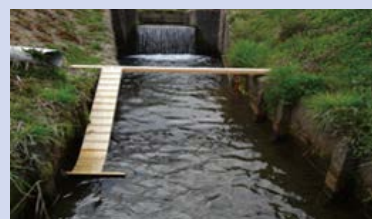
水路からの脱出施設
