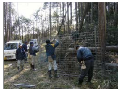
獣害防止柵の補修
