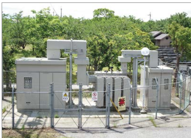
揚水機場の受電設備更新（長浜市）
