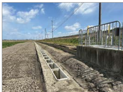
排水路の整備(近江八幡市)
