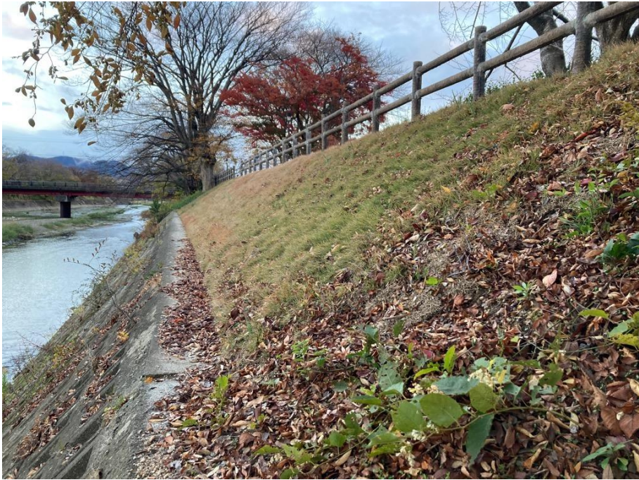
芹川堤防補強工：法面（芝の下）に遮水シートを設置
