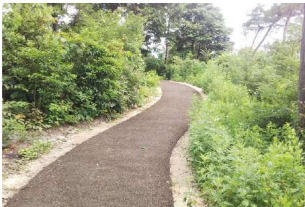
当製品は解体工事や間伐で発生した廃木材をチップ化し、加熱アスファルトと混合する舗装材です。従来木質舗装の課題であった耐久性を向上させ、10年以上の耐用年数、車両の乗り入れにも対応します。1000㎡3cm厚の施工で、約17tのCO<sub>2</sub>を歩道空間に固定することができます（焼却処分との比較）。不要になった木質舗装材を剥がし、再生処理を行うことで再施工が可能です。
