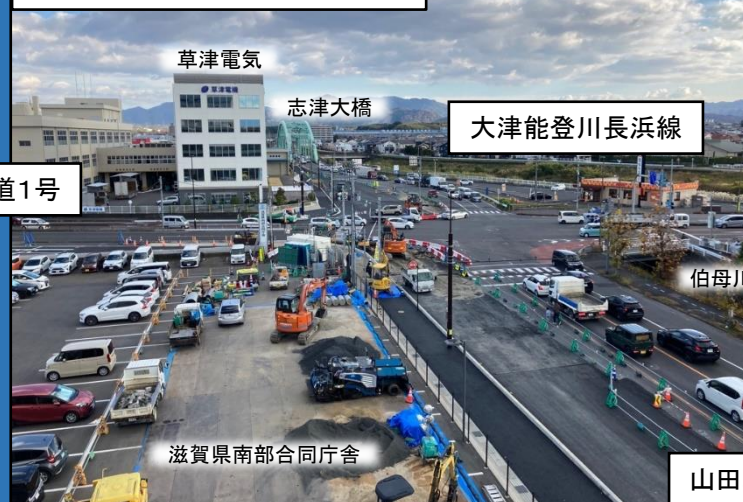
工事中(2024年12月撮影)
