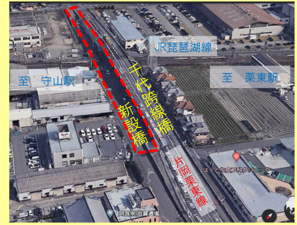
千代跨線橋の横に新橋を整備 4車線化することで渋滞解消を目指す
