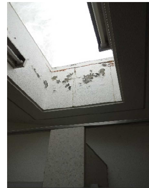
第4駐車場トイレ
