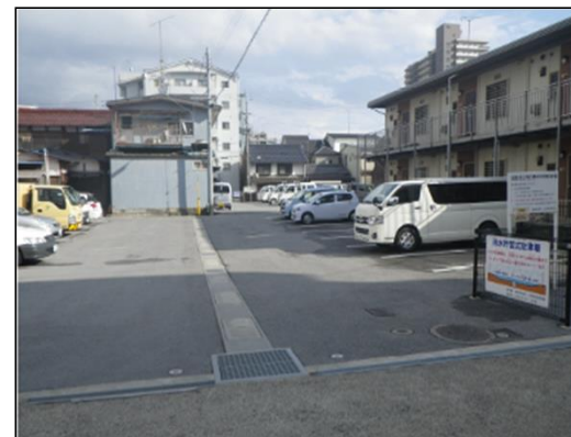
写真：雨水貯留式公用車駐車場（彦根市）
