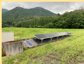
法面などの未利用スペースを活用した太陽光パネル
